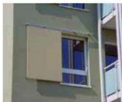
Fenster mit Schiebeläden
